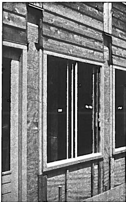
△ De holle stalen kolom wordt gevuld met beton voor de brandwerendheid.
